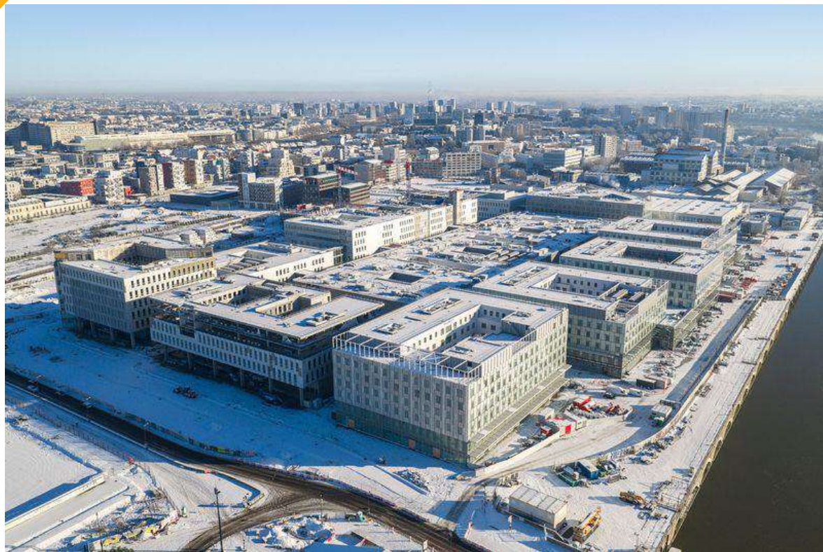
Un nouvel hôpital en construction
